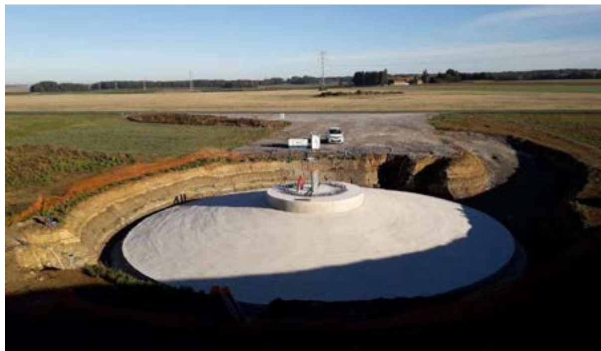
Figure 108 : Fondation après coulage béton
