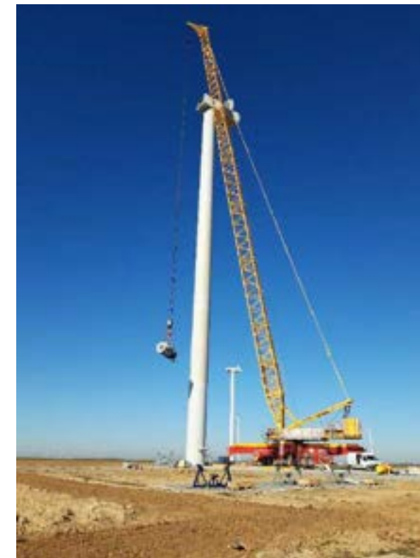
Figure 116 : Montage de la génératrice (Source : VOLKSWIND)
