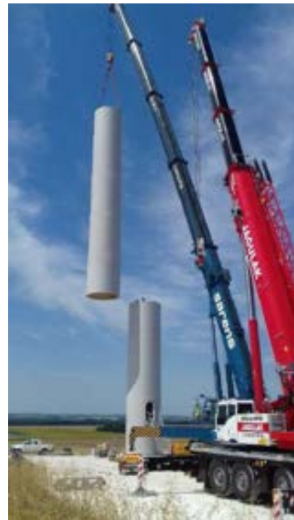
Figure 113 : Montage de la première section du mât (Source : VOLKSWIND)
