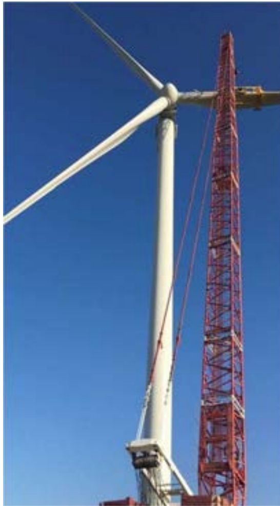
Figure 117 : Montage des pales (Source : VOLKSWIND)
