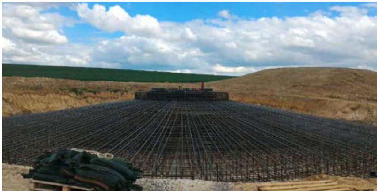
Figure 107 : Ferrailage du massif
