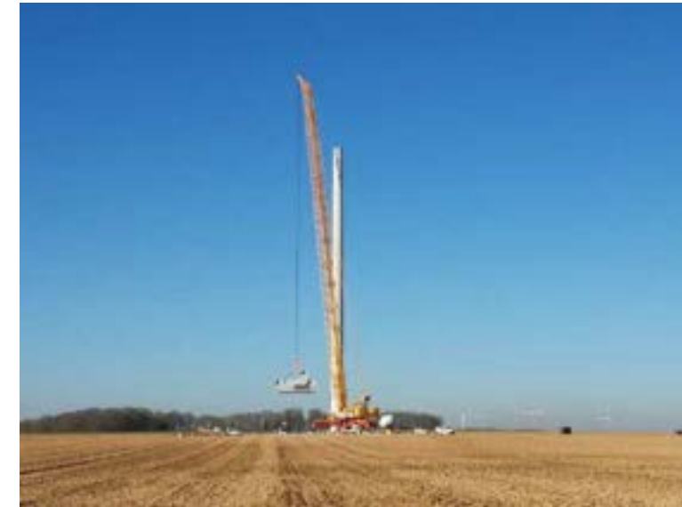
Figure 115 : Montage de la nacelle (Source : VOLKSWIND)
