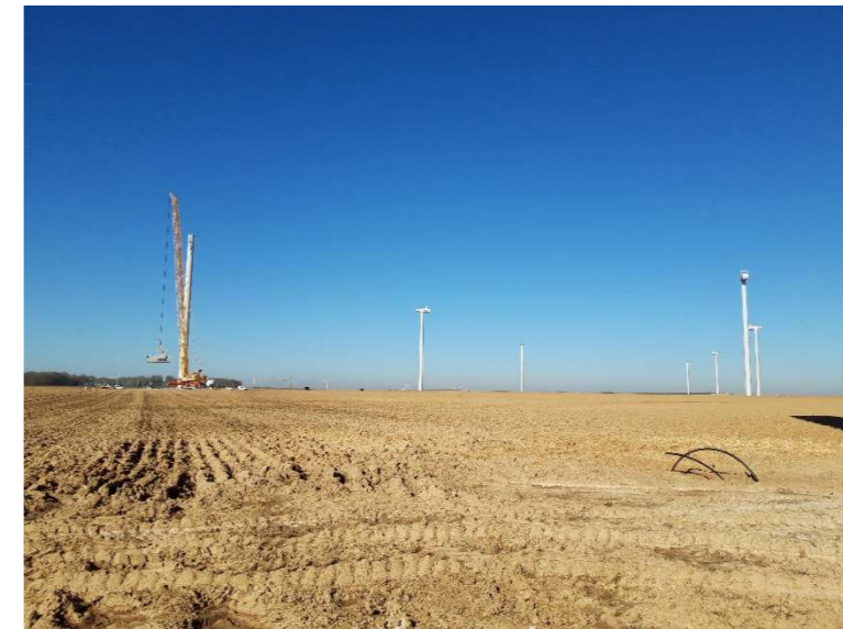
Figure 118 : Un parc de neuf éoliennes Vestas V112 en construction (Source : VOLKSWIND)
