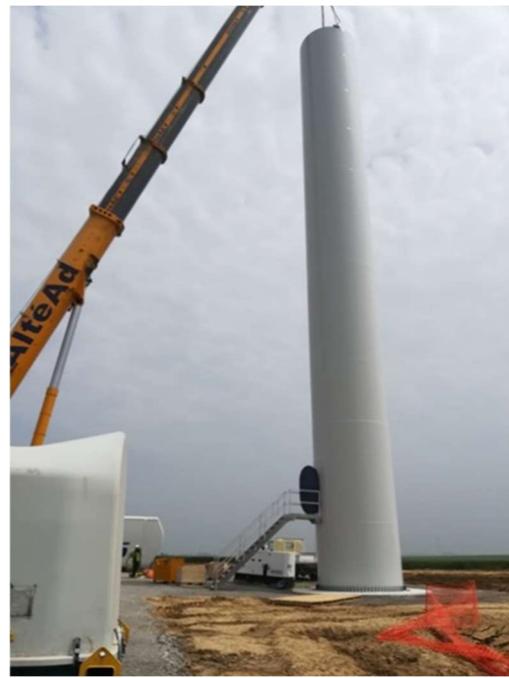
Figure 113 : Montage de la première section du mât (Source : VOLKSWIND)
