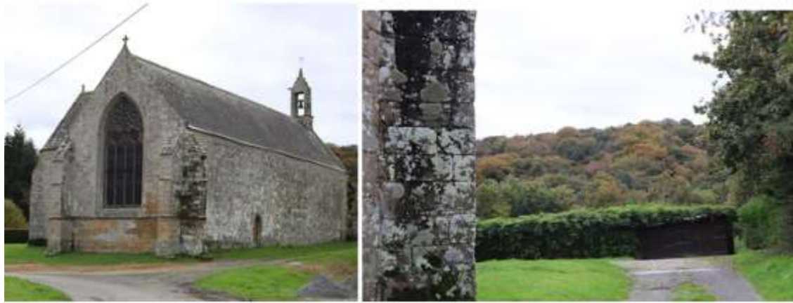
Figure 71 : Chapelle Notre-Dame-d'Avaugour et vue filtrée en direction du projet depuis la chapelle
