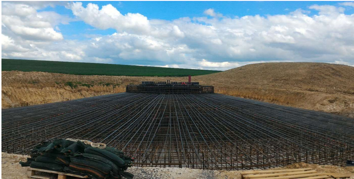
Figure 107 : Ferrailage du massif
