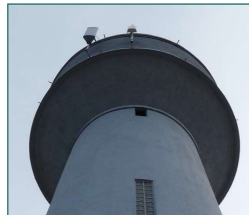
Figure 144 : Installation d'un réémetteur sur un château d'eau
