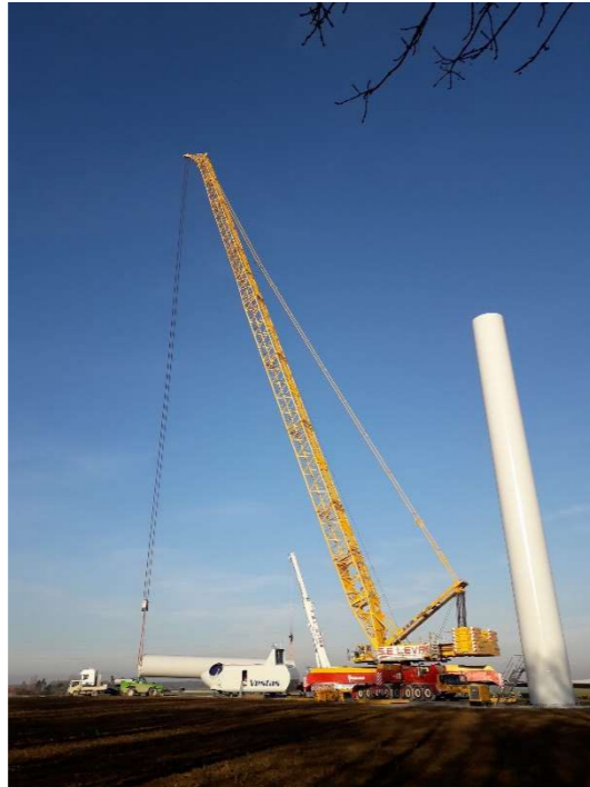
Figure 109 : Grue permettant l'assemblage des différents éléments d'une éolienne
