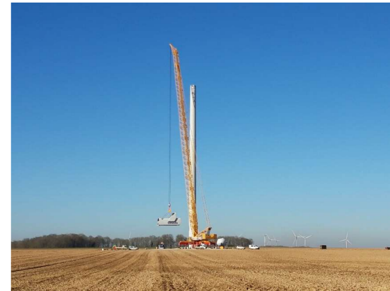
Figure 115 : Montage de la nacelle (Source : VOLKSWIND)
