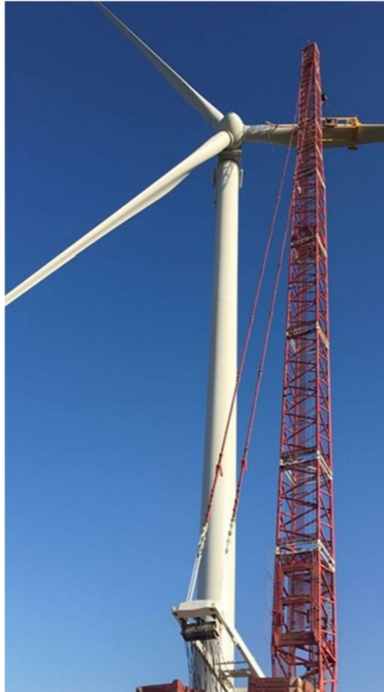
Figure 117 : Montage des pales (Source : VOLKSWIND)
