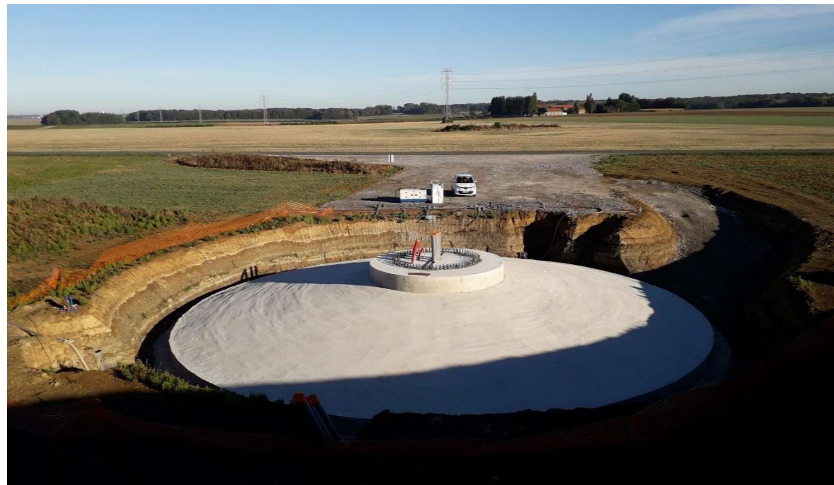
Figure 108 : Fondation après coulage béton
